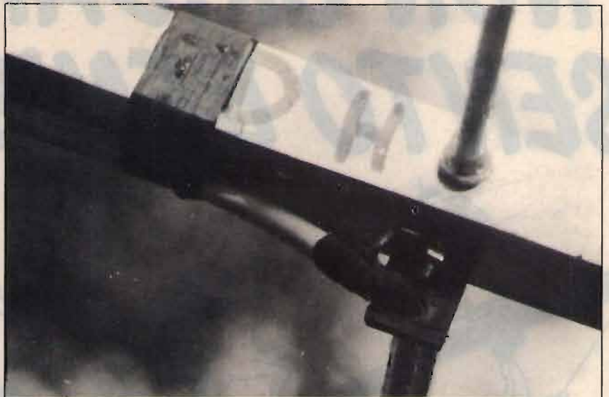
foto 6 Particolare del collegamento cavo-condensatore gamma-match.
